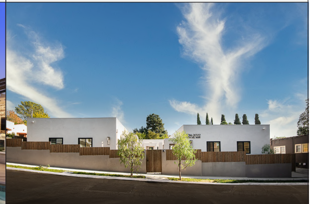
4) 2016 N. VISTA DEL MAR AVE.
